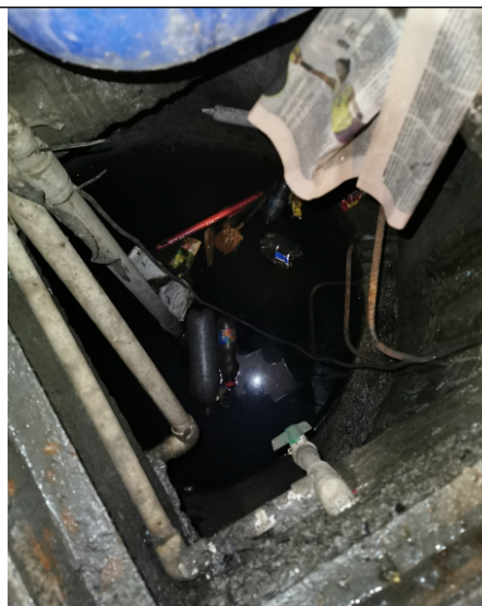
Estado físico de ambiental del aljibe
